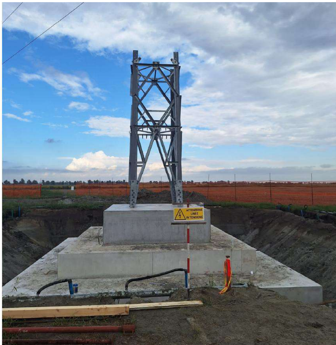
Figura 4.53: Esempio fondazione monoblocco
